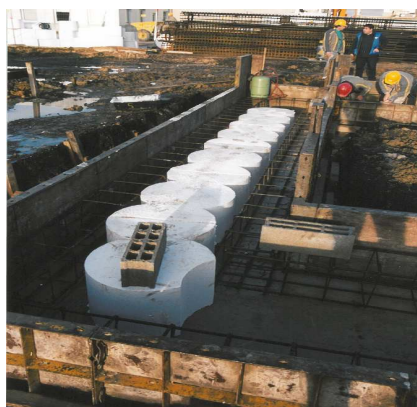
👉 Réservations guide pour perçage de pieux sécants.
