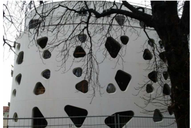
👉 Réservations pour ouverture de fenêtre y compris dans voile cintré.
