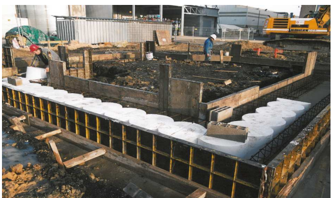
👉 Réservations guide pour perçage de pieux sécants.
